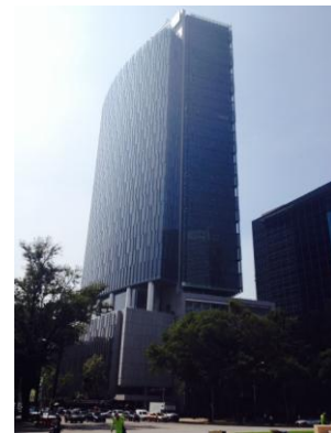
Av. Paseo de la Reforma No. 342, Colonia Cuauhtémoc, Del. Cuauhtémoc.
