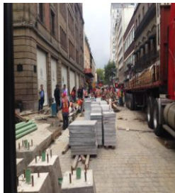
Remodelación de la vía
