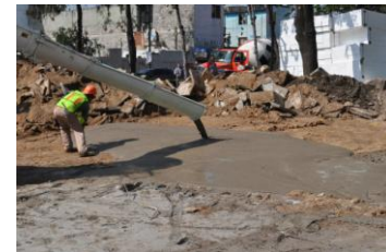
Nivelación del suelo
