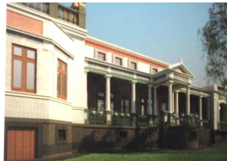
Vista exterior Remodelación
